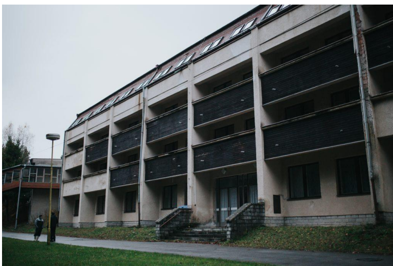
Sigord – budova internátu a telocvične
